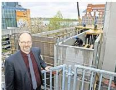
Rektor Benjamin Lang steht vor der Baustelle der HMT Rostock.
