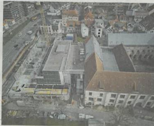
Die hmt Rostock erhält derzeit einen Anbau an der Nordseite. Foto: Mirco Dalchow
